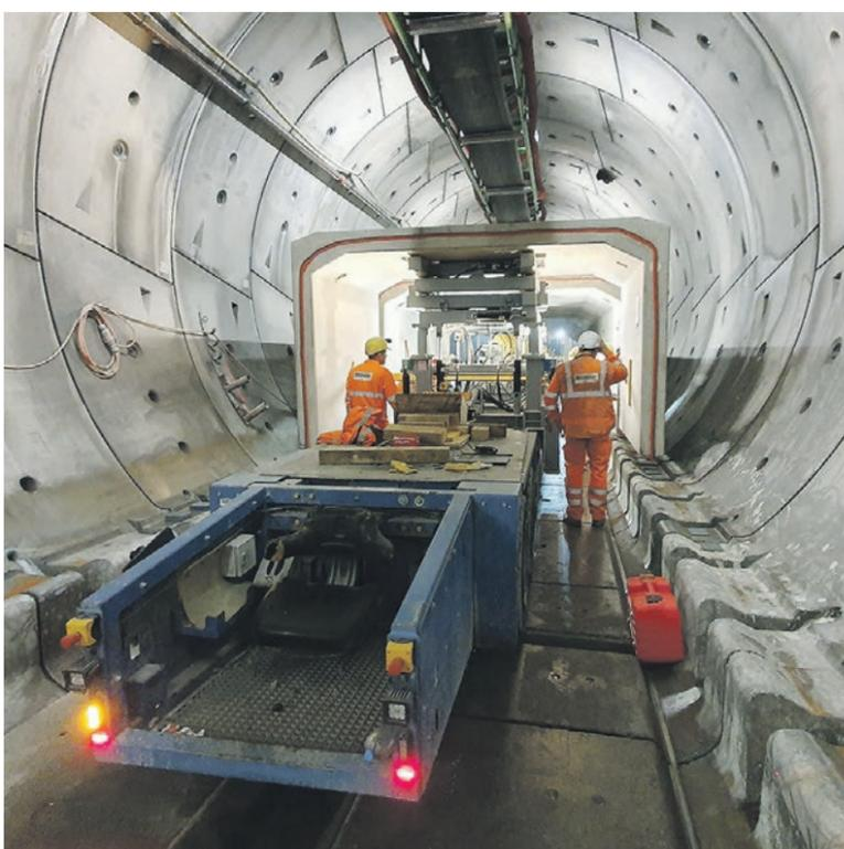
Als Einzelfahrzeug kann das ASV – Automated Service Vehicles – im Tunnel auch Betonfertigteile versetzen und positionieren.
